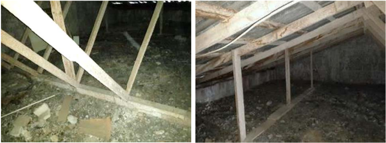
Նկար 7. Տանիքի փայտե շրջանակը և ասբեստաշիֆերից / մետաղյա թաղանթից ծածկը
