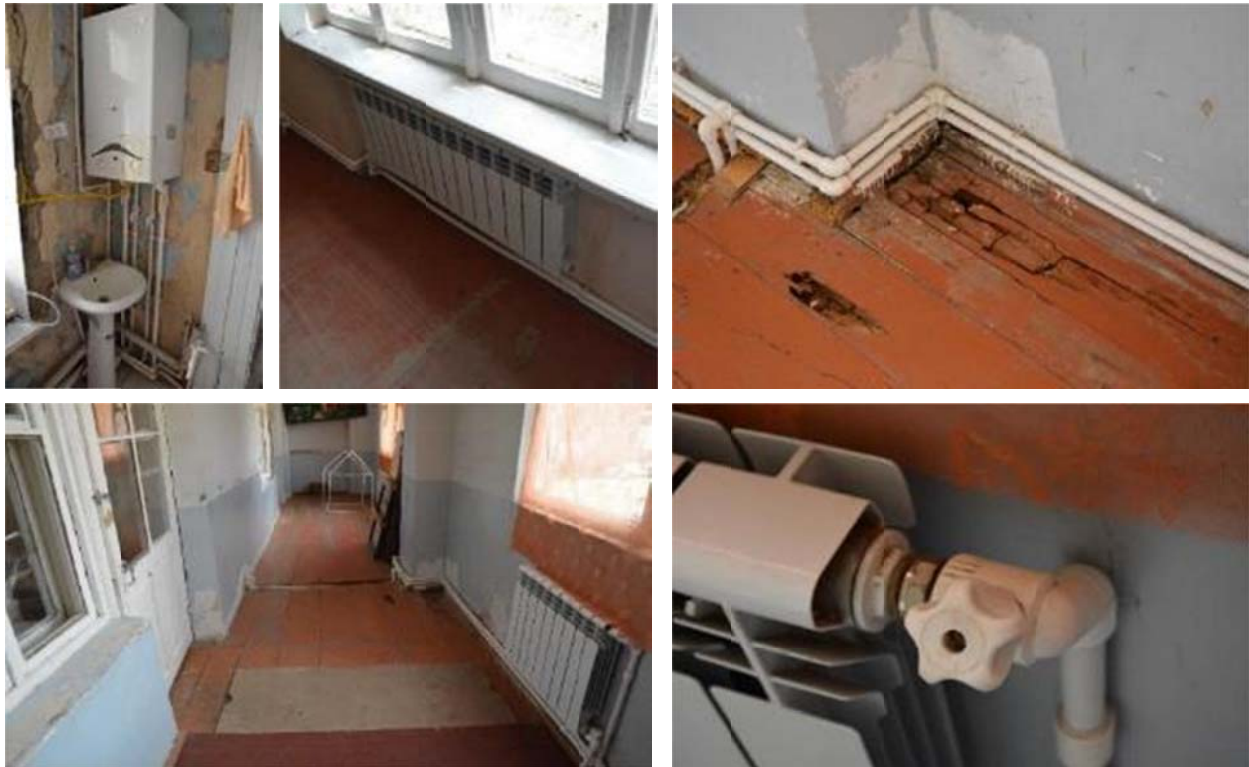
Նկար 10. Մանկապարտեզի ջեռուցման համակարգը. կաթսան, ջերմաբաշխման ցանցն ու մարտկոցները
