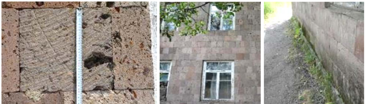
Նկար 7. Մանկապարտեզի շենքի արտաքին պատերը՝ տուֆ քարի շարվածքով
