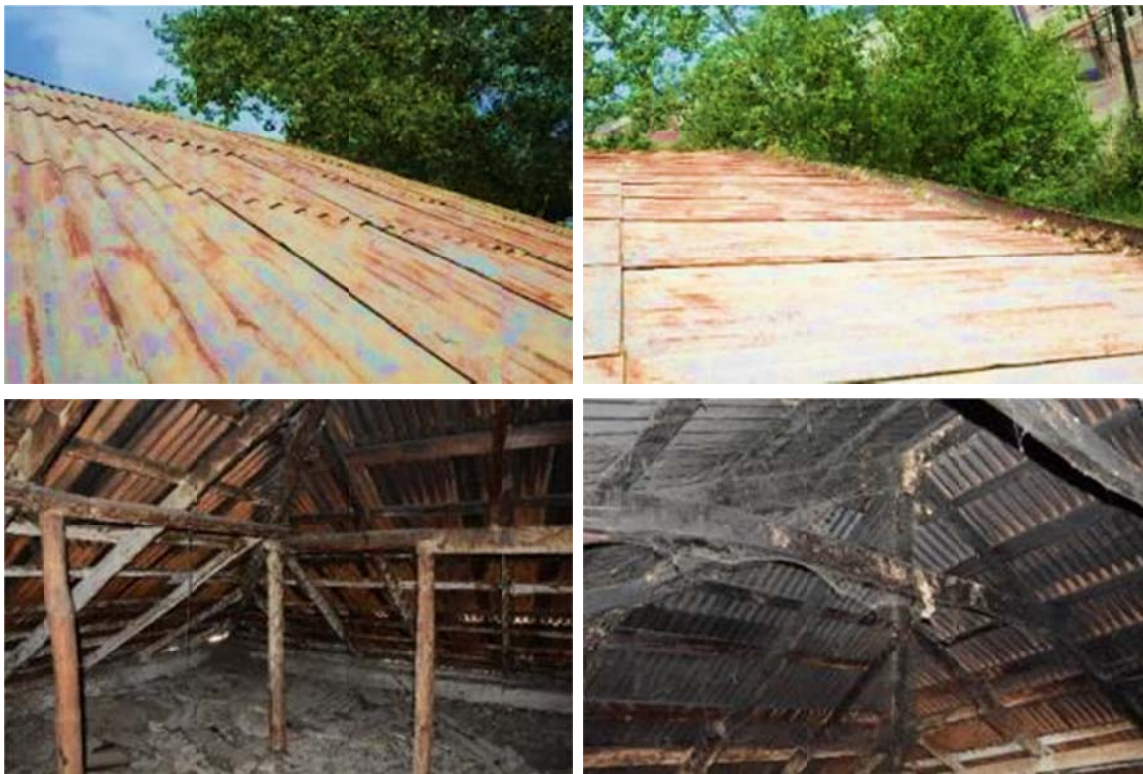
Նկար 8. Տանիքի մետաղյա թաղանթից ծածկը և փայտե շրջանակը
