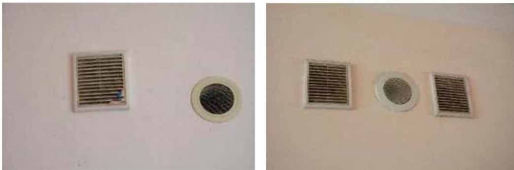
Նկար 11. Օդափոխման հորաններ և օդափոխիչներ
